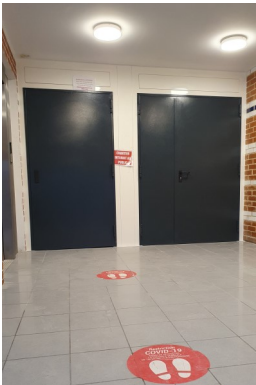
La nouvelle porte d'entrée
